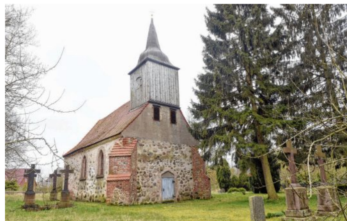
Die Feldsteinkirche wurde in mehreren Etappen gebaut.
